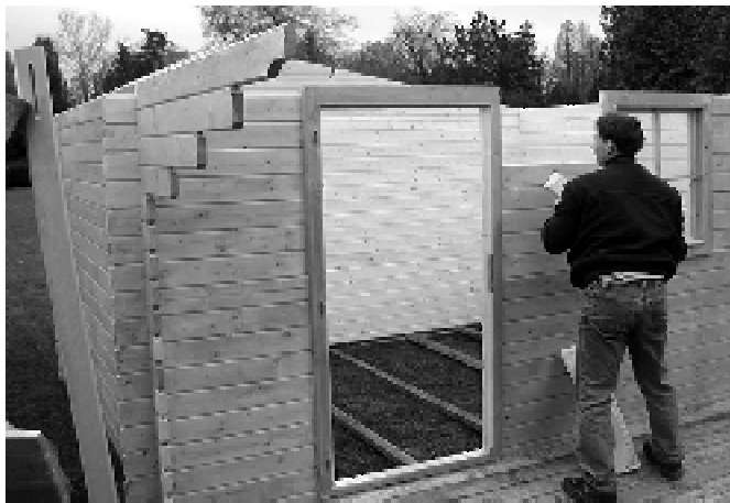
Instalovaná obložka dveří, doplnění stěnovnic do konečné výšky stěny
