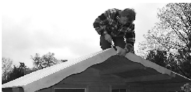
Přibíjení štítového prkna
