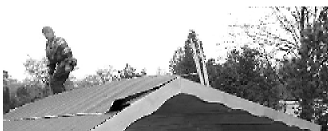
Překrytí hřebene lepenkou
