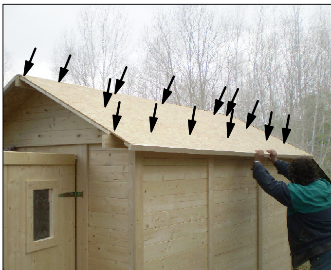
Obrázek 24: OSB střecha, použité vruty 4x40 mm
