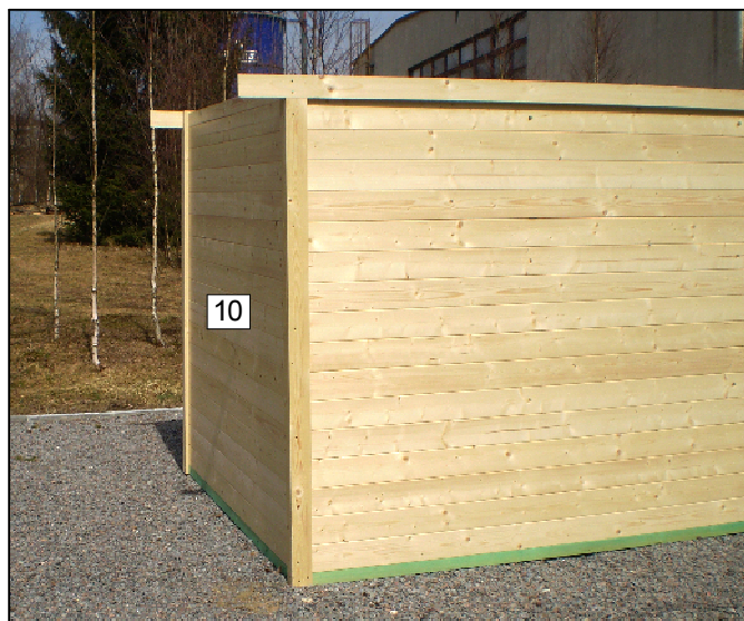
Obrázek 16: Dokončená montáž zadní stěny
