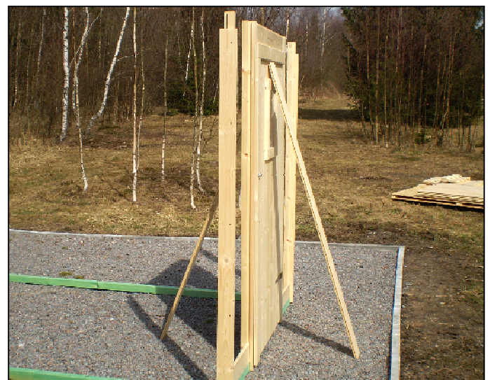
Obrázek 10: Zajištění panelu proti pádu
