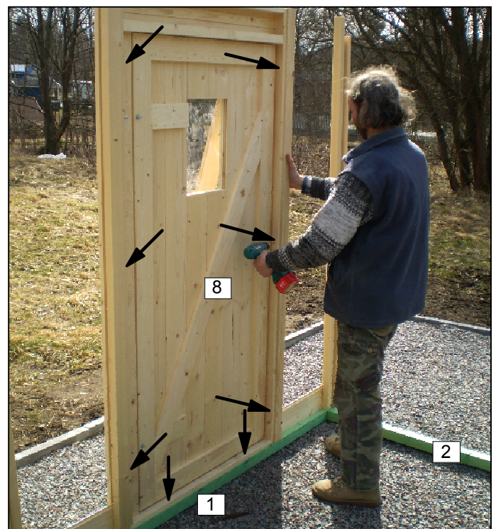
Obrázek 9: Montáž dveřního panelu, použité vruty 4x40 mm
