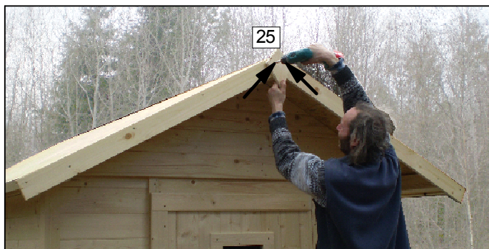
Obrázek 26: Ozdoba, použité vruty 4x40 mm
